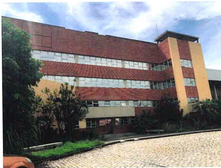
Figura 4 - Fachada prédio administrativo
